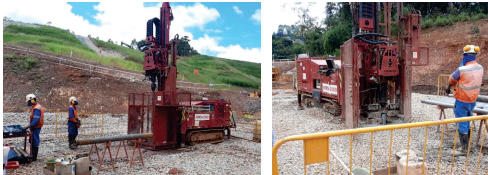
Figura 1 – Sonda sônica em atuação em investigação de fundação na região do Quadrilátero Ferrífero (MG).
