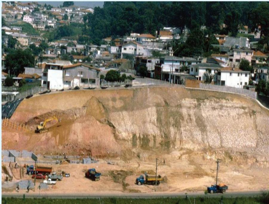
Figura 1. Talude instável em obra de implantação de posto de gasolina na Av. Escola Politécnica, São Paulo. Cobertura pedológica e tecnogênica sobre o embasamento cristalino (à esquerda) e sedimentos terciários (à direita). Foto: A.M.S.Oliveira, 1998.
