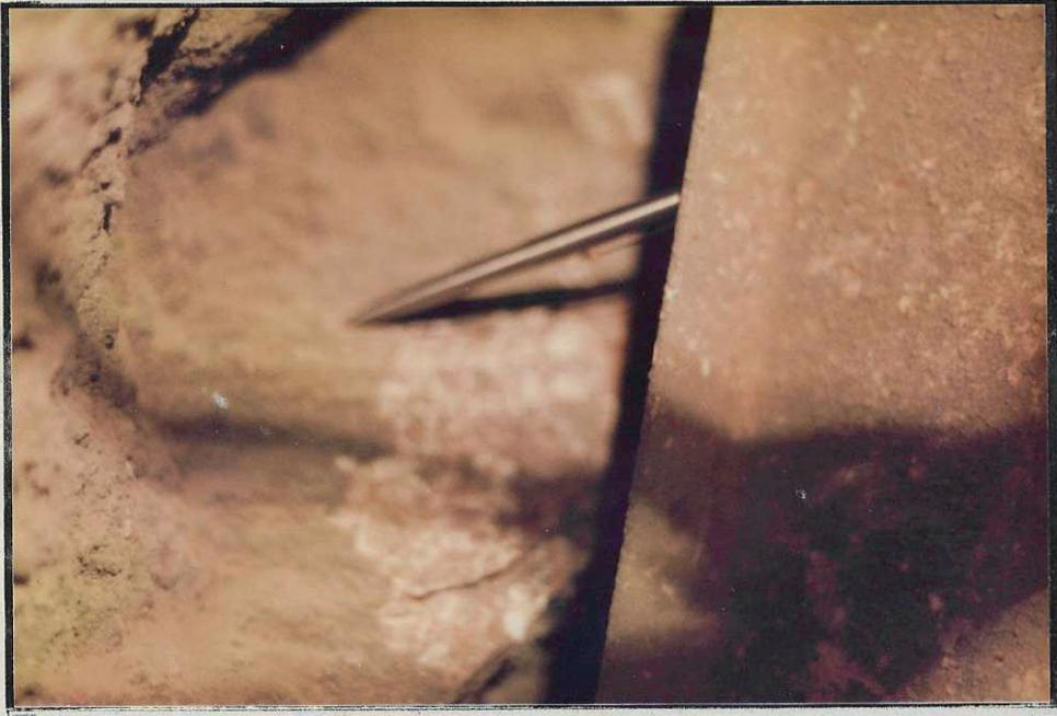
Foto 9 - Arco metálico no consolidado a las paredes del túnel.
