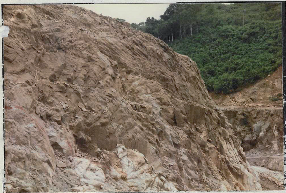
Foto 12 - Detalle del nivel inferior de la hombrera izquierda en andesita y ignimbritos practicamente sanas.
