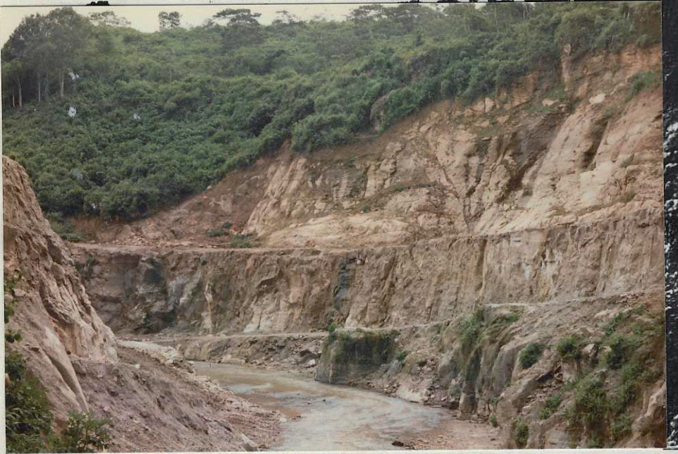
Foto 11 - Eje de la presa y hombrera derecha.
