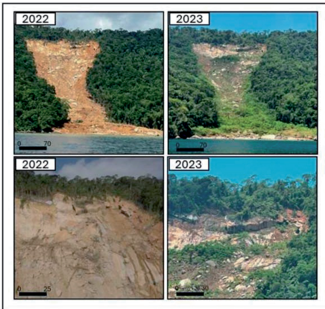
Figura 10 - Área da cicatriz de deslizamento em 2022, logo após o deslizamento e em 2023, um ano após o evento.
