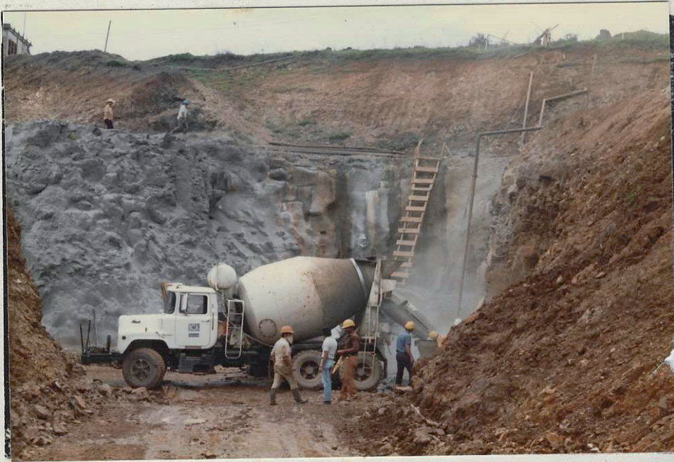
Foto 1 - Embocadura del túnel 1, en andesitas fracturadas. Las fotos 2, 3 y 4 fueron hechas en las excavaciones para la embocadura.
