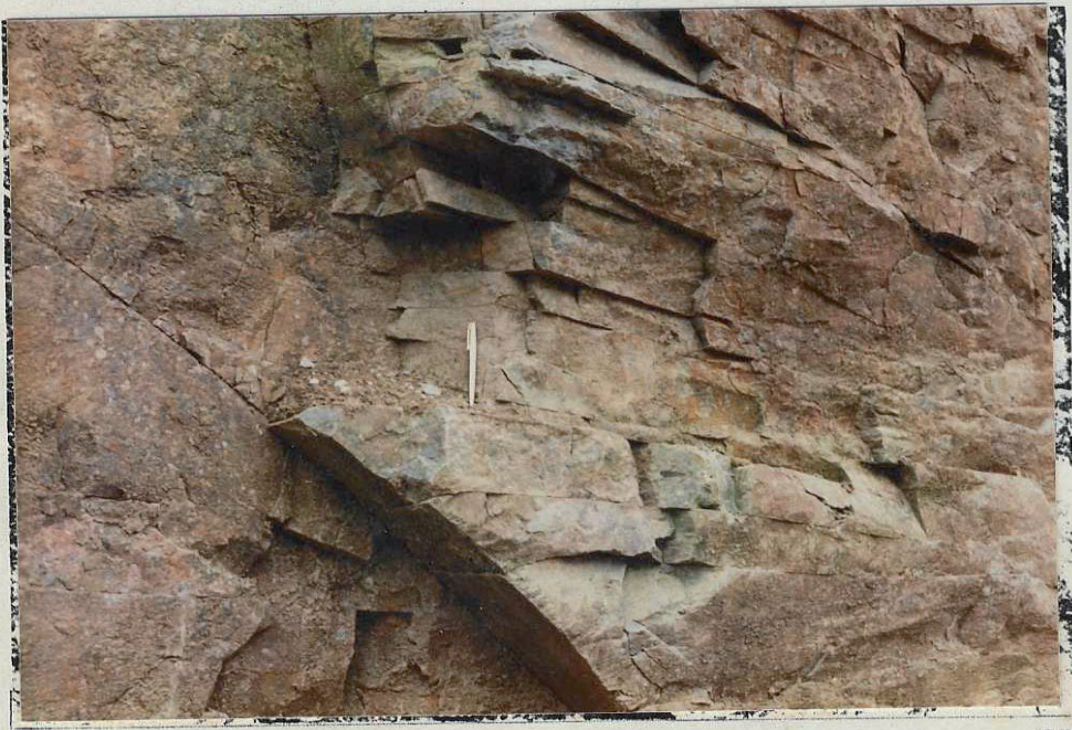
Foto 4 - Andesita: praticamente sana Trecho de < 5 fracturás/m : classe II Trecho de 6 a 20 fracturas/m : classe III
