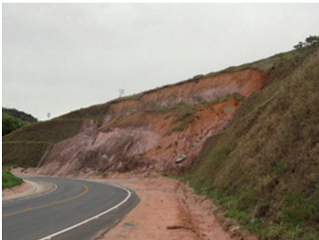
**Figura 17** - Escorregamento em corte de estrada, expondo espesso regolito. Esta unidade de terreno apresenta alta suscetibilidade a deslizamentos planares ou escorregamentos rotacionais na massa de solo (entre os horizontes B e C ou em descontinuidades do saprolito). Rodovia ES-014, entre as localidades de Mimoso do Sul e Conceição do Muqui.
