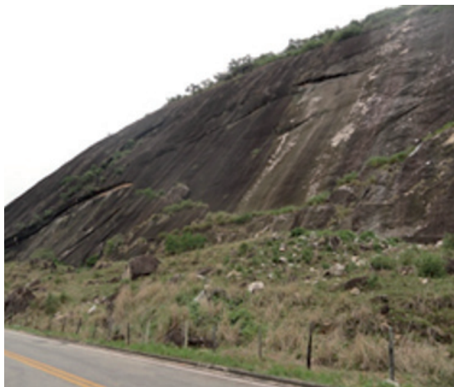
Figura 20 - Paredão rochoso com evidências de juntas de alívio de tensão, demonstrando alta suscetibilidade a queda de lascas e deslizamentos de solos rasos (Neossolos Litólicos) no contato solo-rocha. Serra Santa Rosa, Mimoso do Sul/ES.
