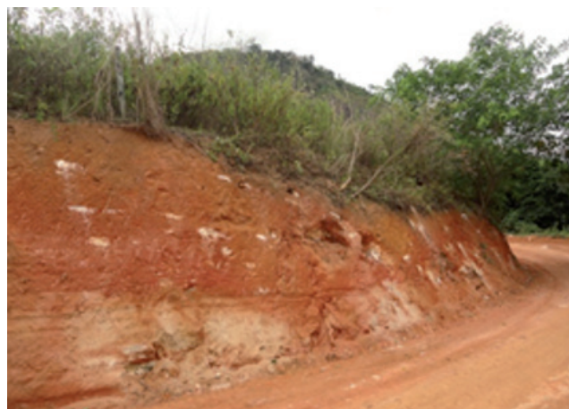
Figura 23 - Depósito coluvionar, rico em blocos decimétricos e solo residual sotoposto em corte de estrada vicinal no vale do rio Paraíso, Mimoso do Sul/ES.
